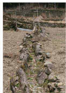
縦方向の排水路
